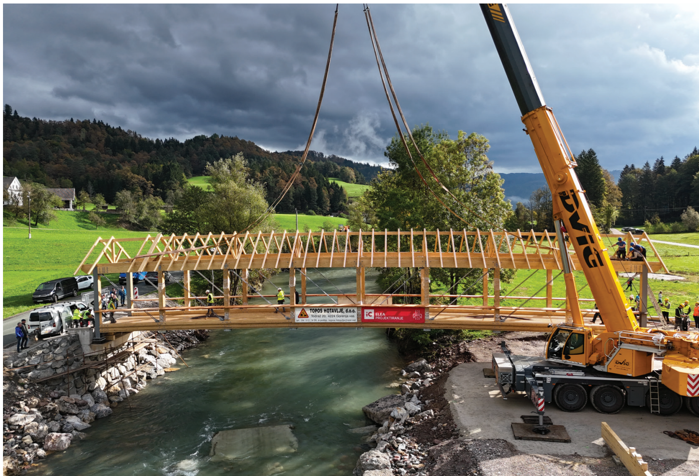
Slika 8. Nosilna konstrukcija po namestitvi na krajna opornika, oktober 2024.
