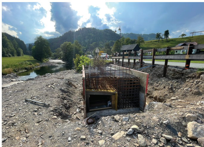
Slika 3. Gradnja AB krajnega opornika, avgust 2024.
